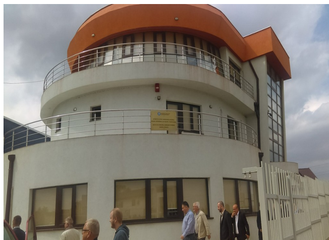
Zgrada komandnog centra OT Vrancea
