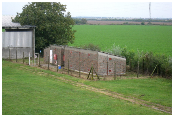
Skladište otopine na RC osijek
