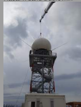
Radarski c band Zadar/Debeljak postavljanje radoma
