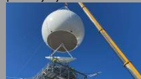
Radarski c band Uljenje Pelješac postavljanje radoma
